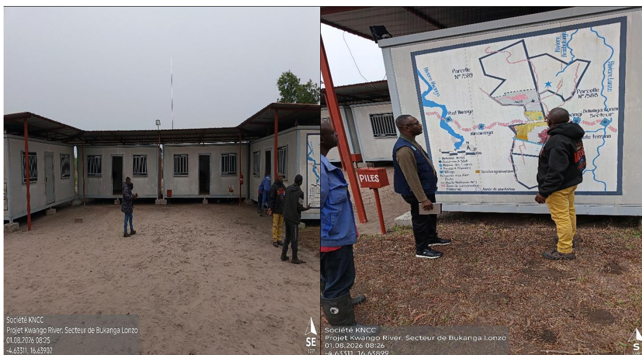
Photo 5 : vue du bâtiment administratif Photo 6 : le chef de site donne des explications à l'Expert de l'ACE
