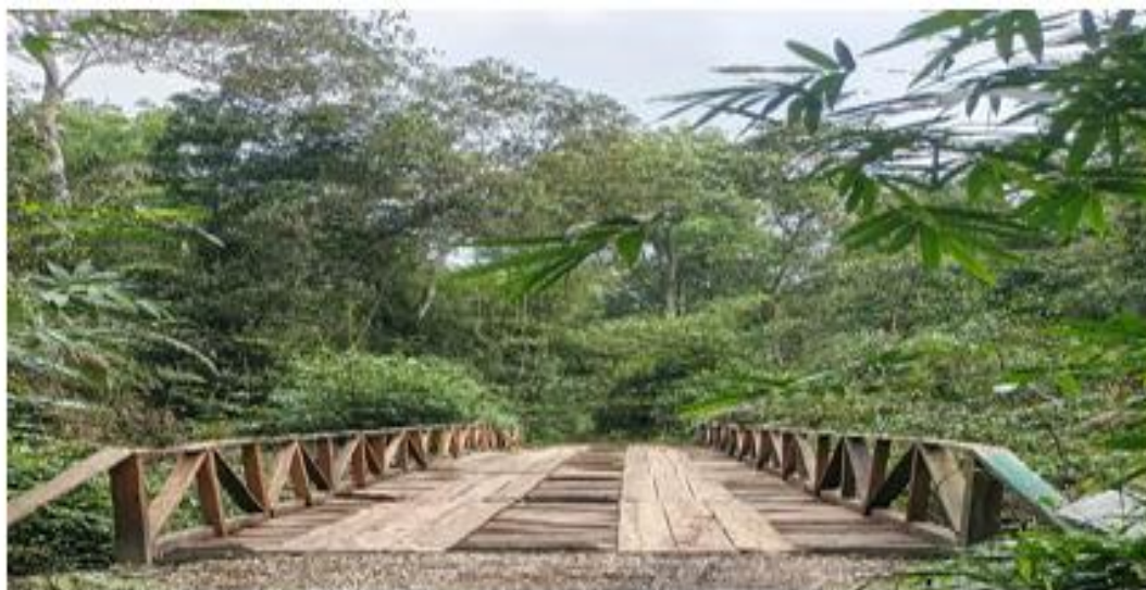
Photo 21 : Pont construit par la Société KNCC sur le tronçon BOONIA (Chef-lieu du secteur) à MANGANYA
