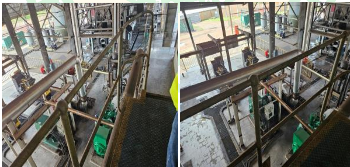
Photo 6 : l'Usine de production de LUKUMETE
