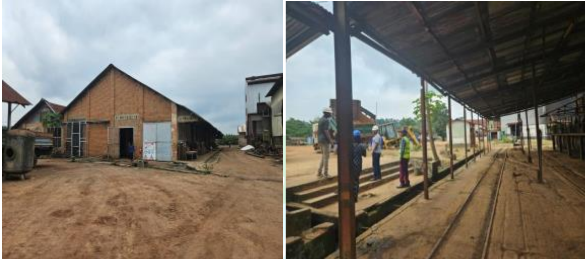
Phot 2 : L'Usine de PHC LOKUTU non opérationnelle
